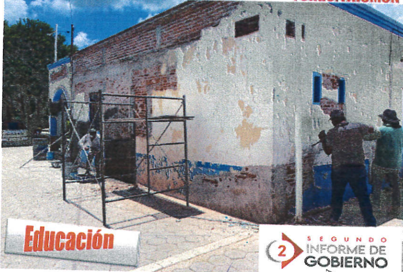
Obra: Rehabilitación de Biblioteca Niños Héroes Inversión: $736,194.55 Fondo: FAISMUN
